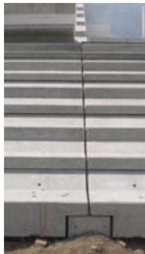
Aufbau der gegossenen Fertigbetonteile
