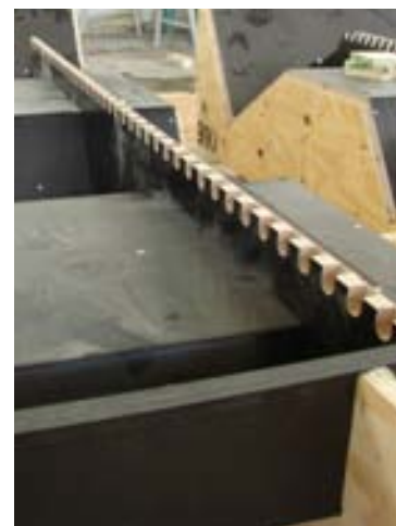
Fertigung der Holzschalung
